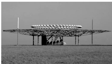
Gambar 2 Konfigurasi 49 Antena DVOR
